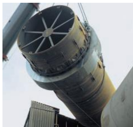
Cambio del aro de rodadura de salida del horno.
