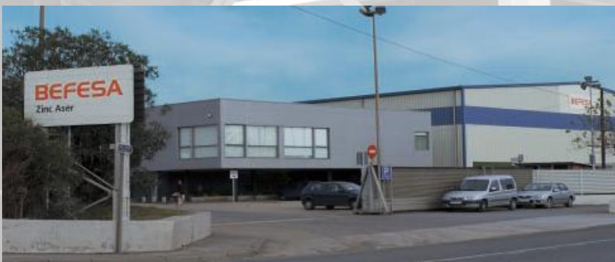
Entrada Befesa Zinc Aser.
