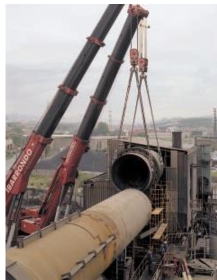
Cambio del aro de rodadura de salida del horno.
