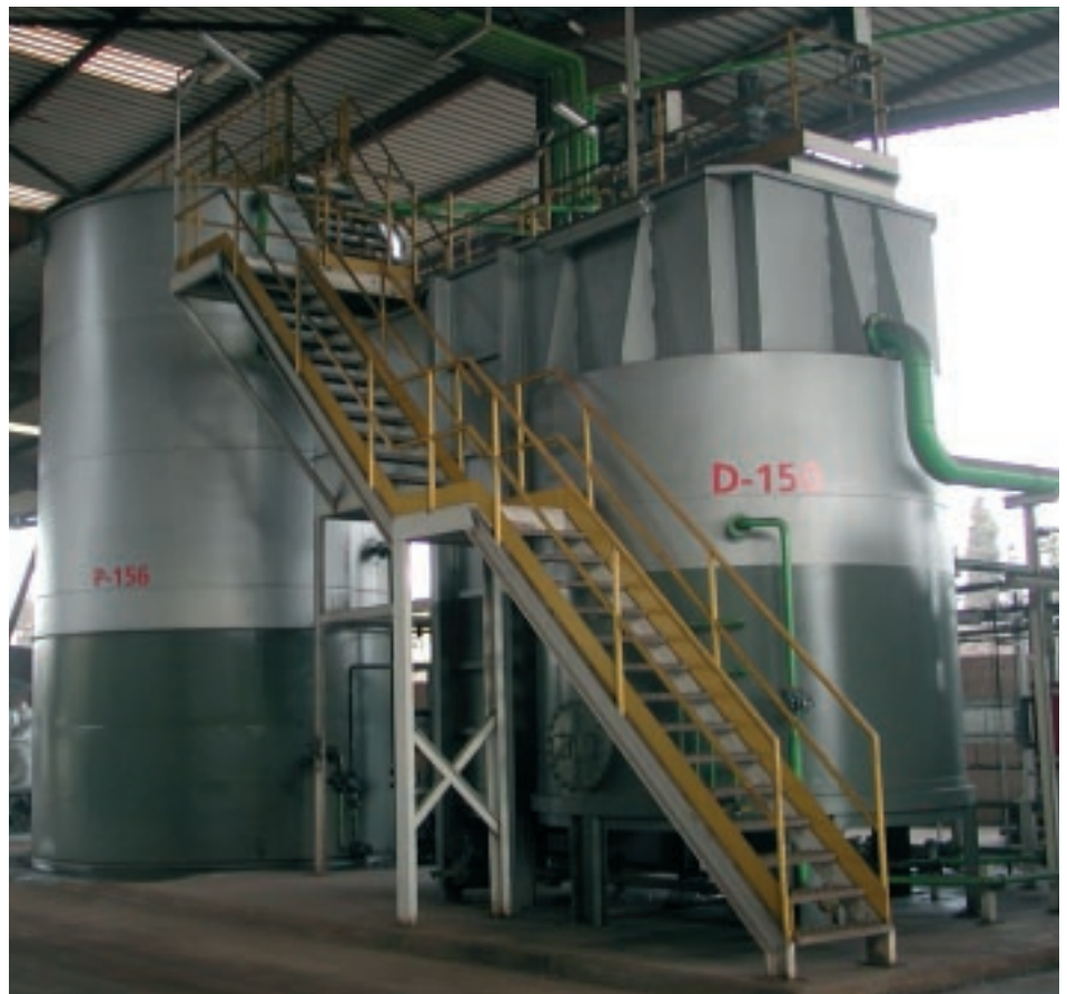
Nueva planta de tratamiento de efluente.
