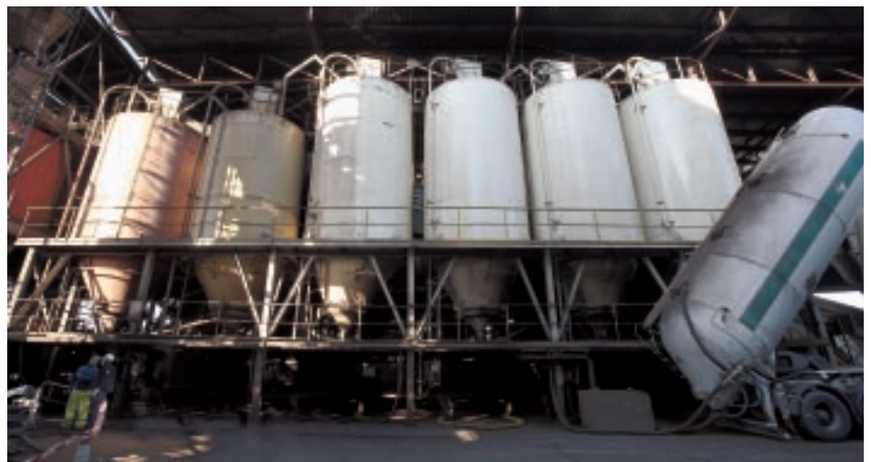
Ampliación silos de descarga.
