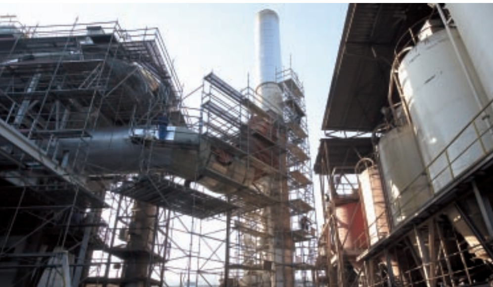
Conexión del nuevo sistema de depuración de gases a la chimenea Waelz.
