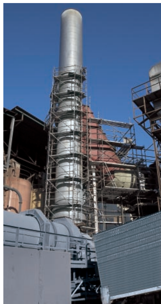
Chimenea del horno Waelz, obras de conexión con el nuevo sistema de depuración de gases.
