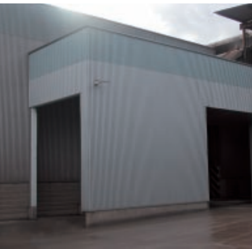
Túnel de carga de camiones.
