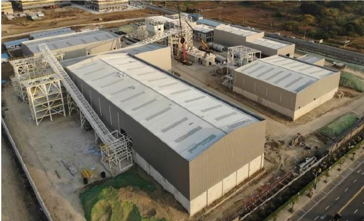
Luftaufnahme der Bauarbeiten in Changzhou, Provinz Jiangsu, November 2020
